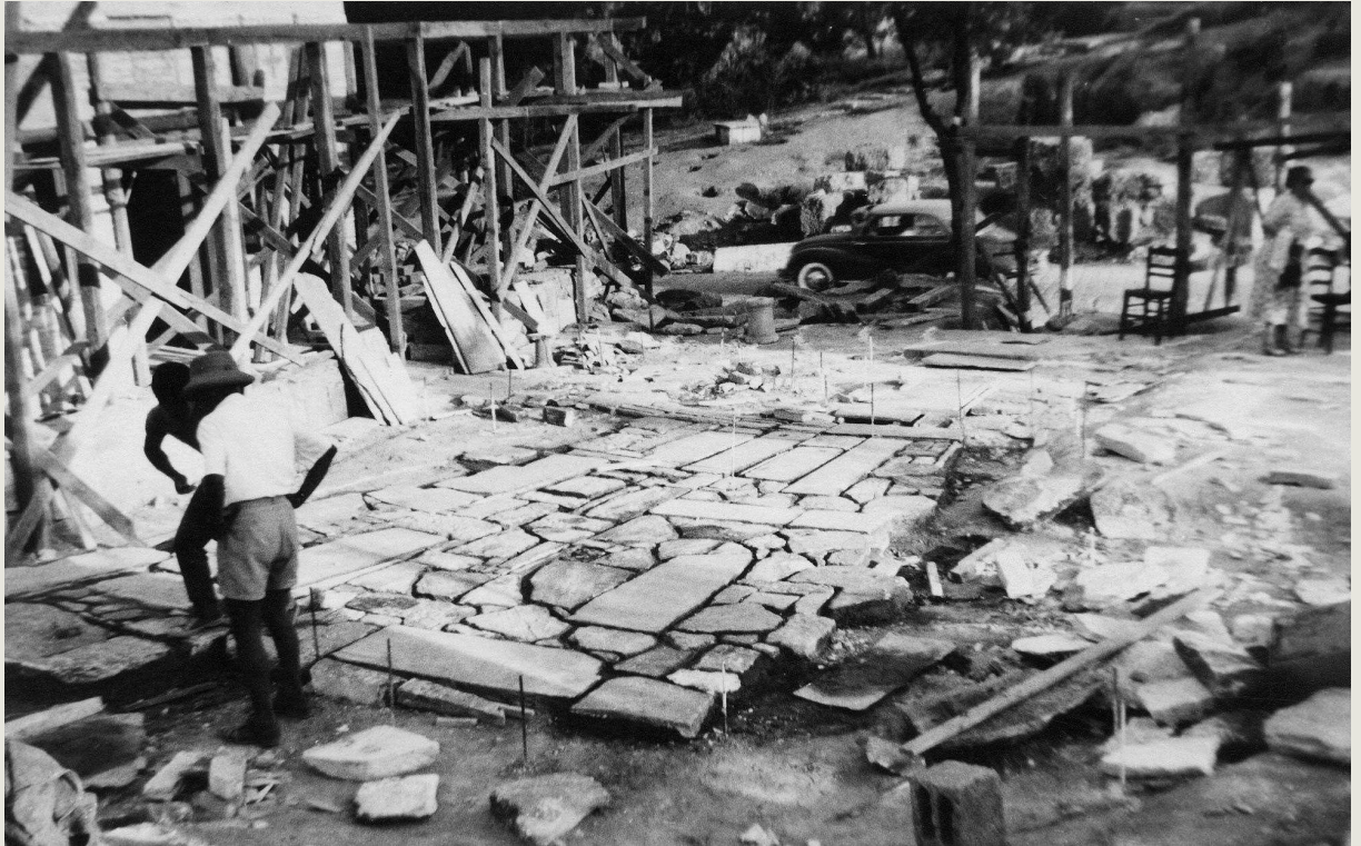
Caminos en construcción. Colina Filopapos Atenas, Grecia. Dimitris Pikionis. ca. 1956 © Foto de autor desconocido
